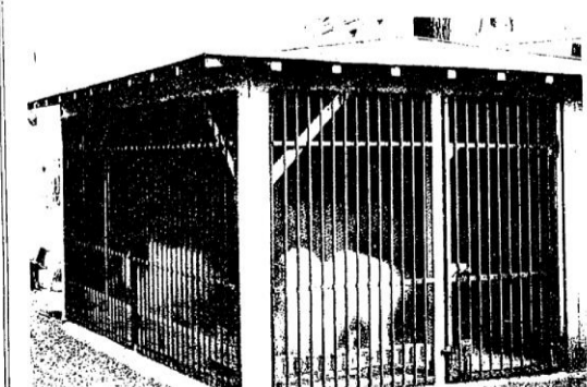
LE CHENIL COUVRE. — Ce chenil est fermé par des barreaux sur lesquels est tendu un grillage de fer. L'entrée du chenil est munie d'une porte en fer forgé, avec un toit en tôle ondulée.
